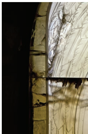
Dégradation du verre
