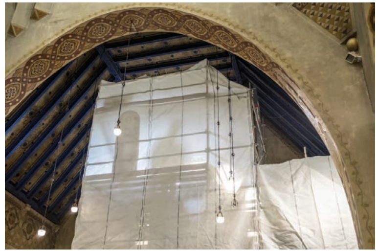
L'un des échafaudages en place.
